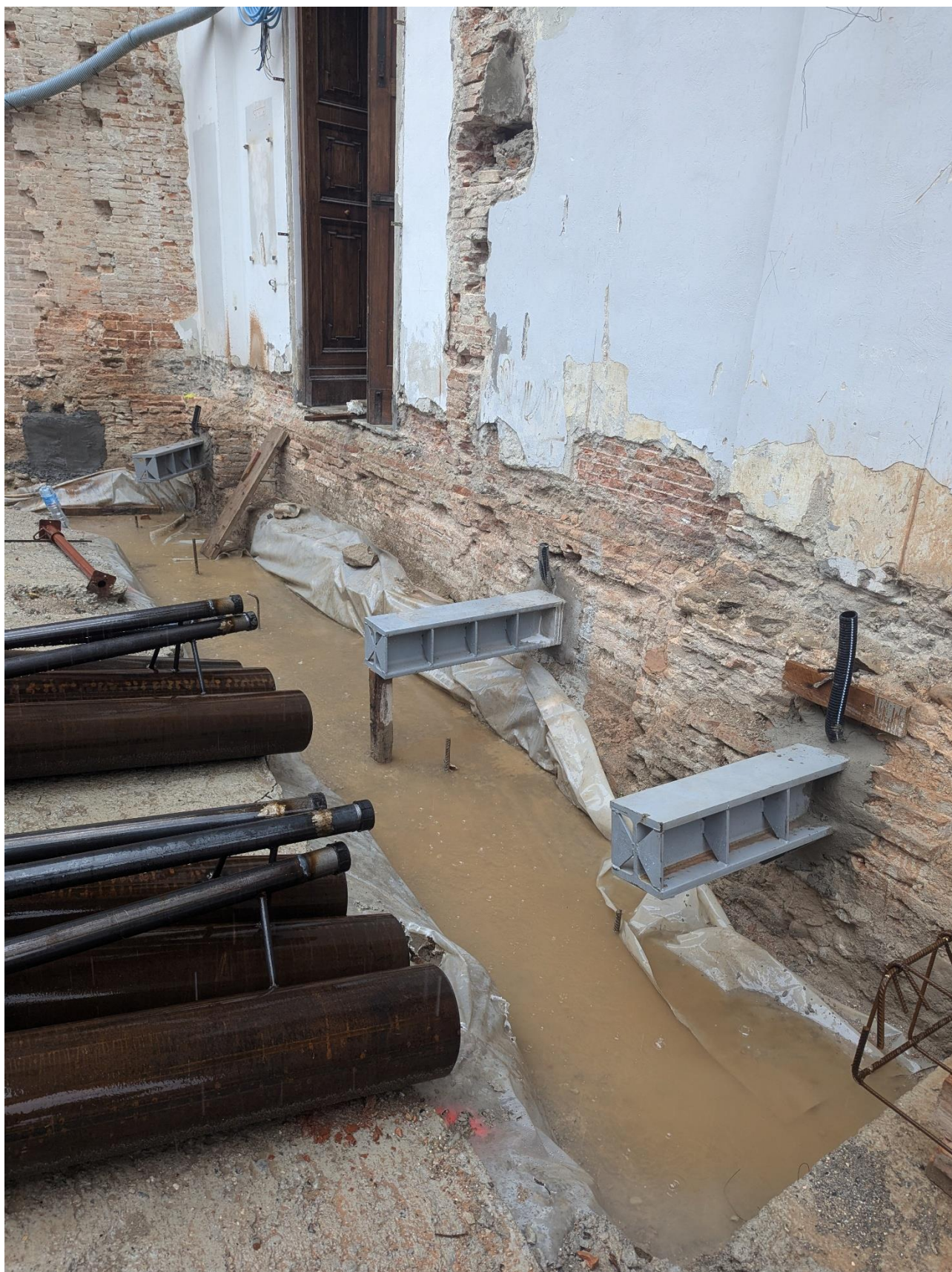
Figura 19 – Le travi a mensola infisse nelle murature della chiesa prima della realizzazione del cordolo armato di coronamento. In primo piano i tubi-guida necessari all'applicazione dei pali infissi.
