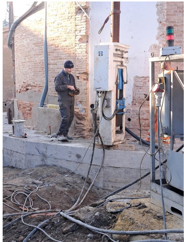
Figura 21 – La macchina spingi-tubo per l’infissione dei pali a pressione nel terreno.
