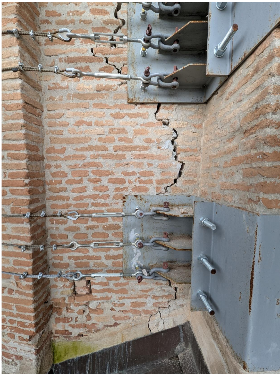
Figura 11 – Particolare degli ancoraggi dei trefoli in acciaio inox necessari alla messa in sicurezza della cappella
