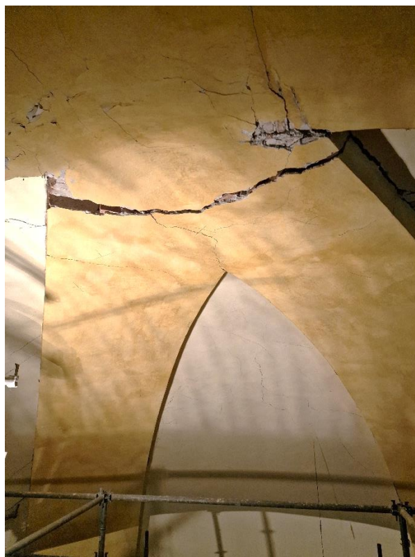
Figura 7 – Lesioni di distaccamento della semicupola dall'arco principale della cappella.
