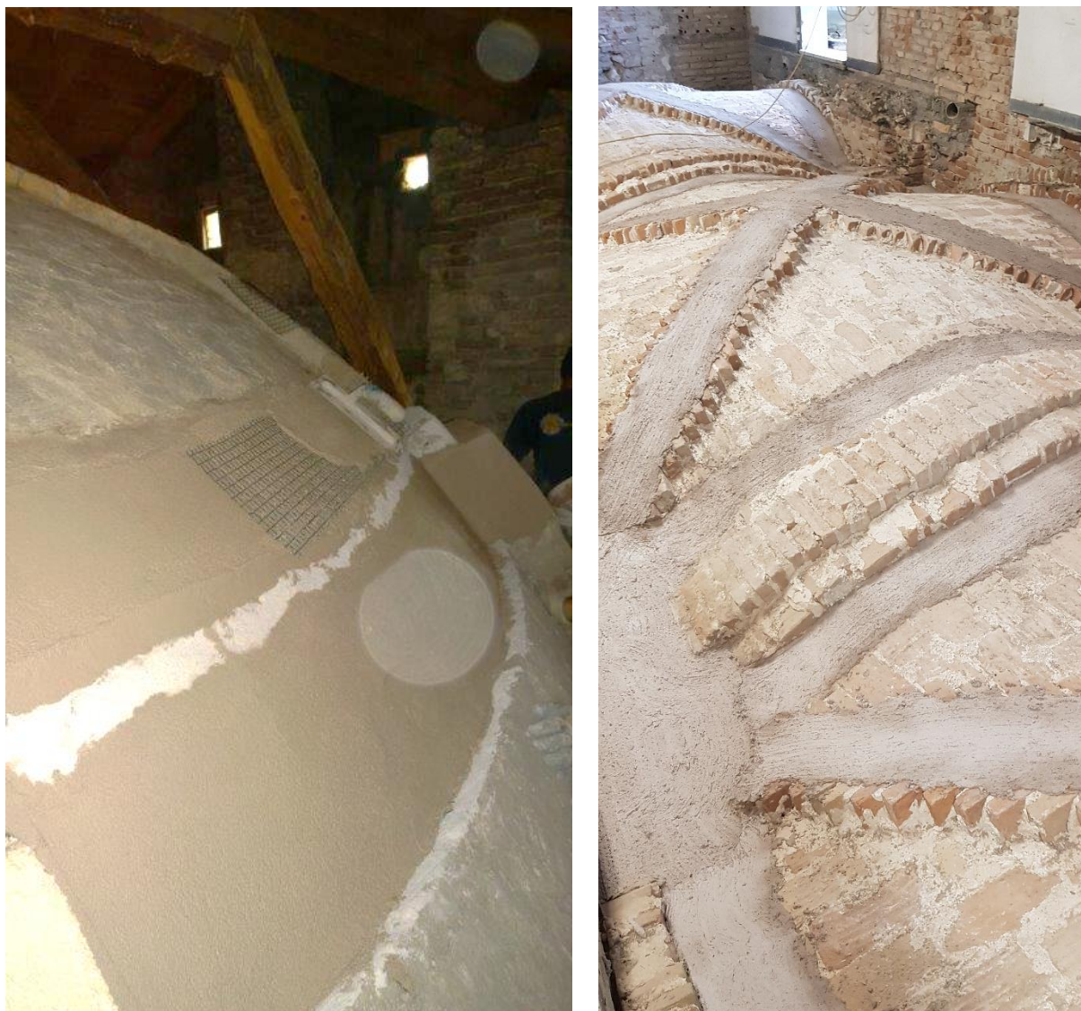
Figura 30 – Esempi di altri cantieri dello Studio Marco Peroni Ingegneria di cerchiature di cupole e di fasciature di costoloni di volte.
