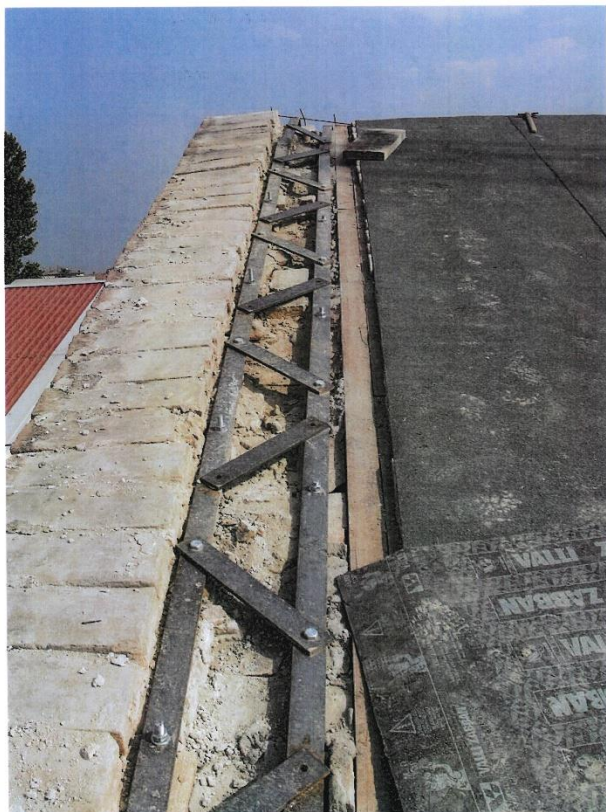
Figura 31 – Il cordolo-tirante previsto al livello dell'imposta del coperto (a sx un esempio di un cordolo-tirante a binario realizzato dal nostro Studio per una chiesa di Faenza)
