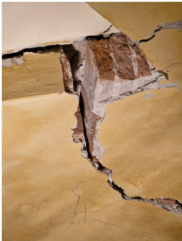
Figura 7 – Lesioni di distaccamento della semicupola dall'arco principale della cappella.
