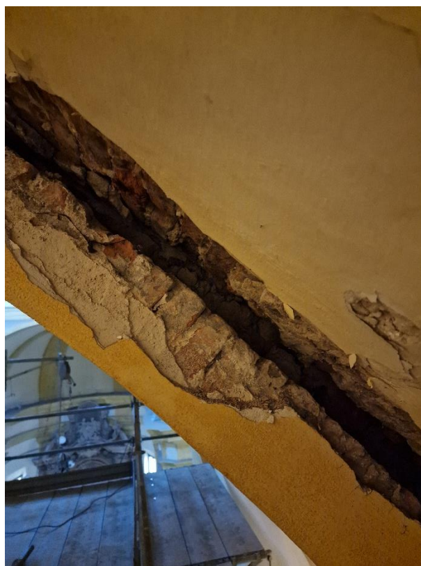
Figura 8 – Particolare del distaccamento della semicupola dall'arco
