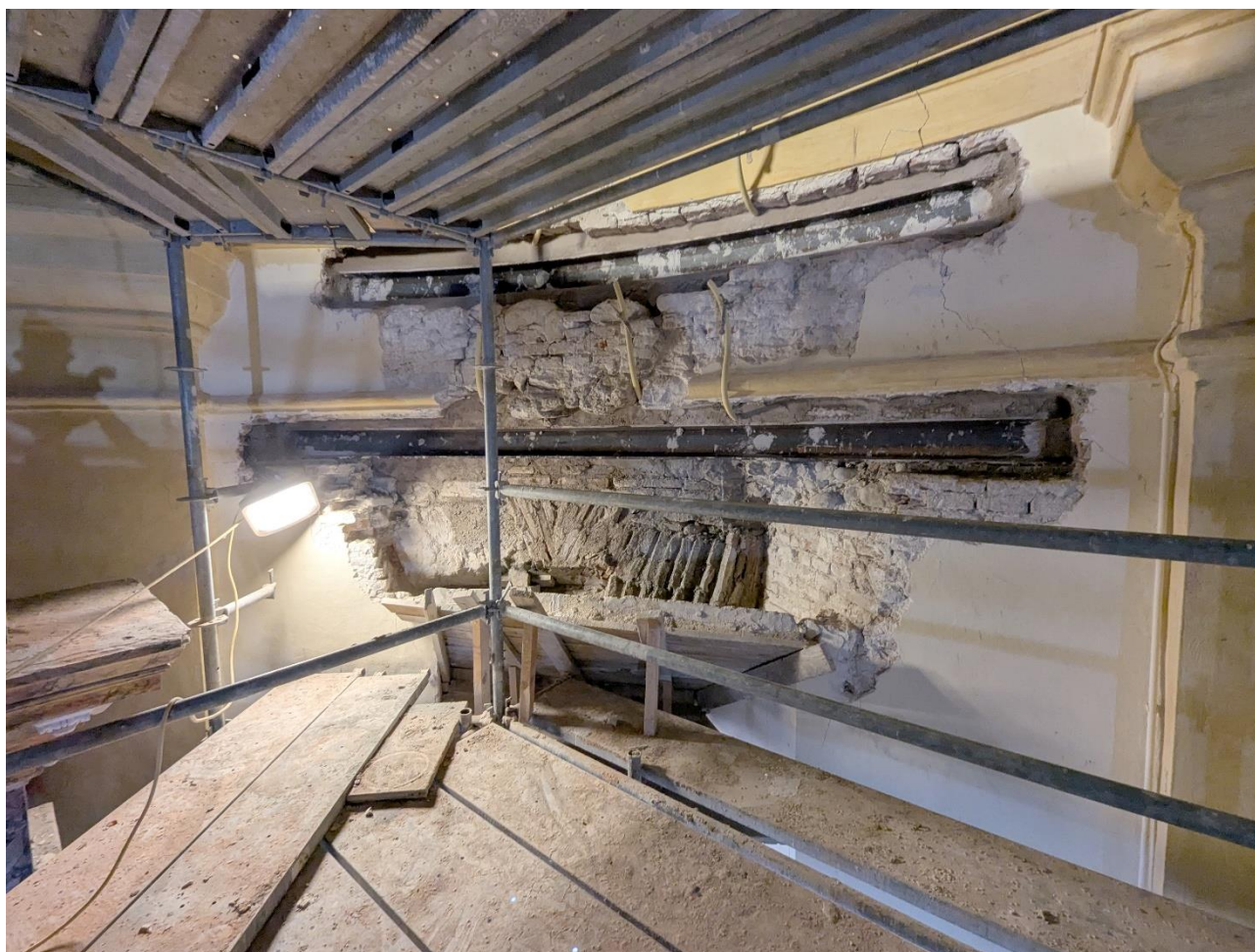
Figura 28 – Architravature calandrate al di sopra delle aperture della cappella atte a ricucire le grosse lesioni presenti.
