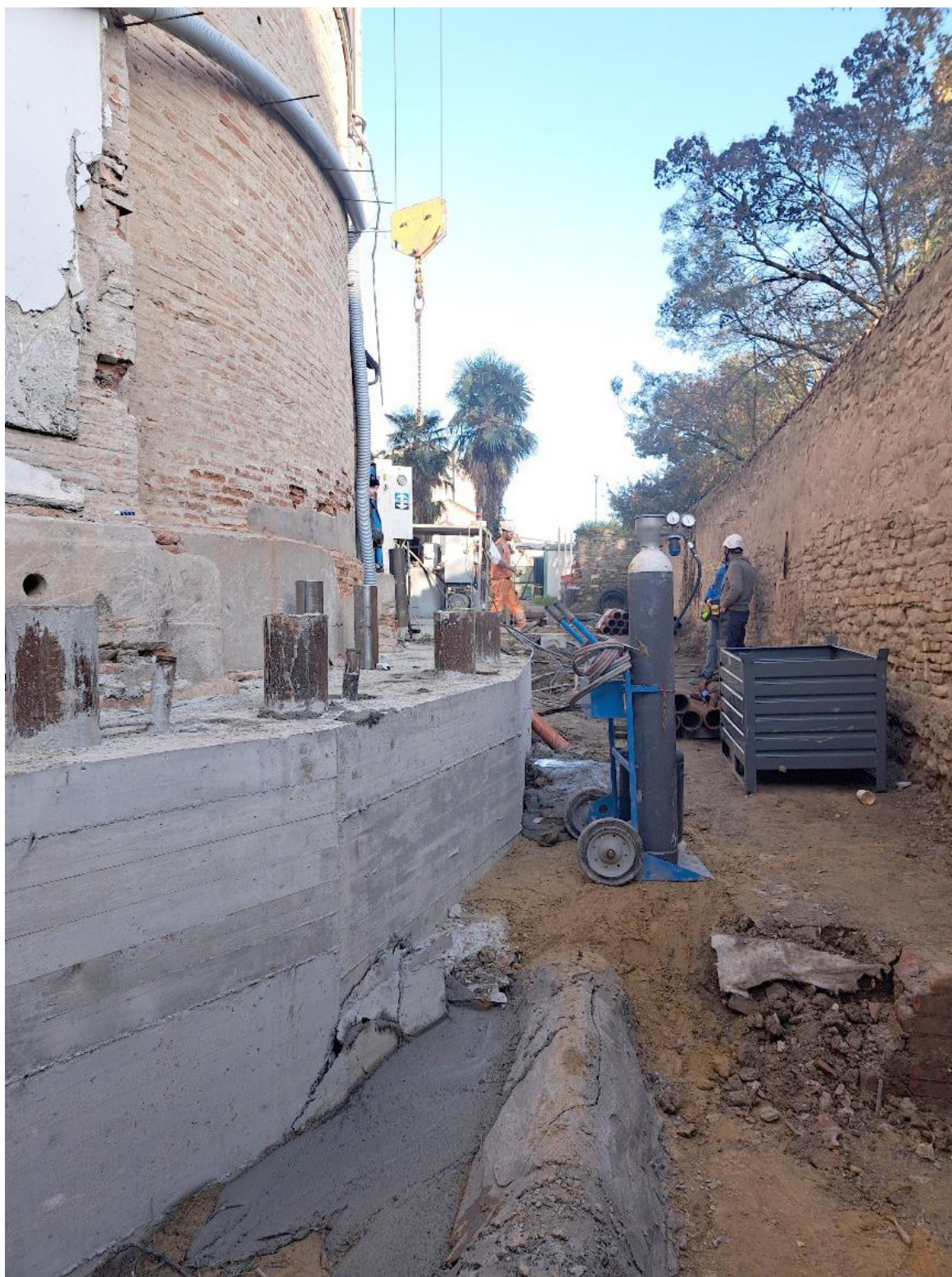
Figura 20 – Cordolo fondale di coronamento gettato. Si notino i tubi guida che escono dal getto e il piccolo tubo per iniettare il cemento man mano che il palo scende nel terreno.
