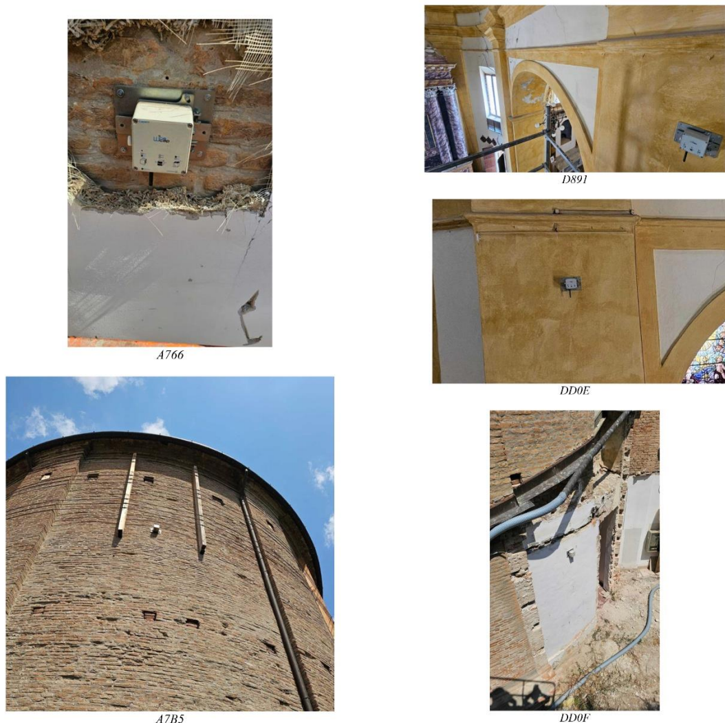
Figura 15 – Rilevatori centesimali installati all'interno e all'esterno della cappella per monitorarne i movimenti
