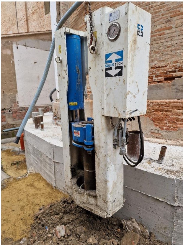
Figura 21 – La macchina spingi-tubo per l’infissione dei pali a pressione nel terreno.
