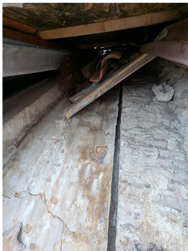
Figura 7 – Lesioni di distaccamento della semicupola dall'arco principale della cappella.
